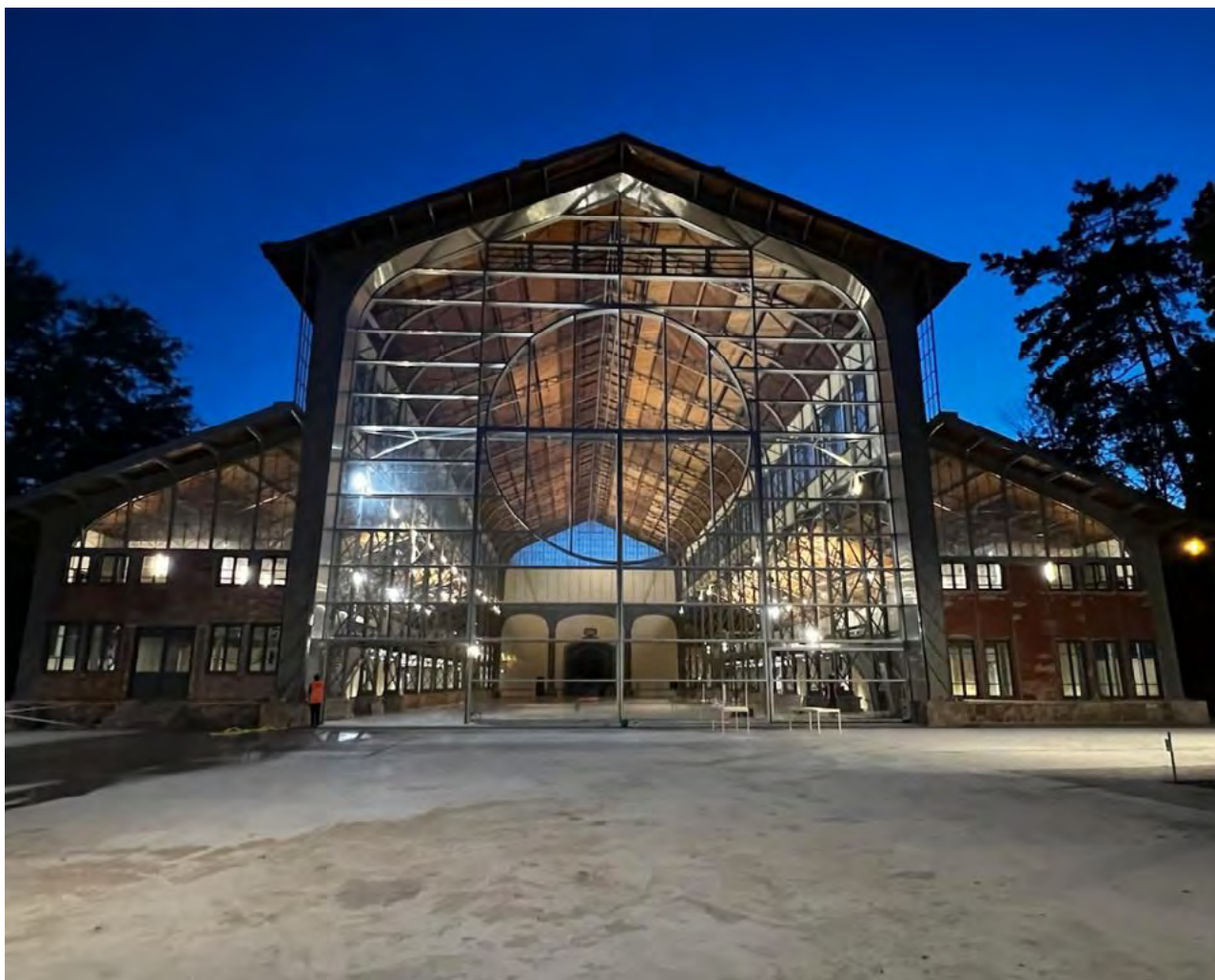
Hangar Y : entrée sud (crédit star's up)
