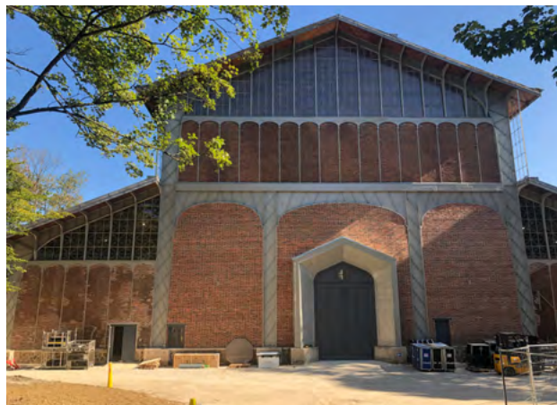
Hangar Y : entrée nord (crédit Jean Molveau)
